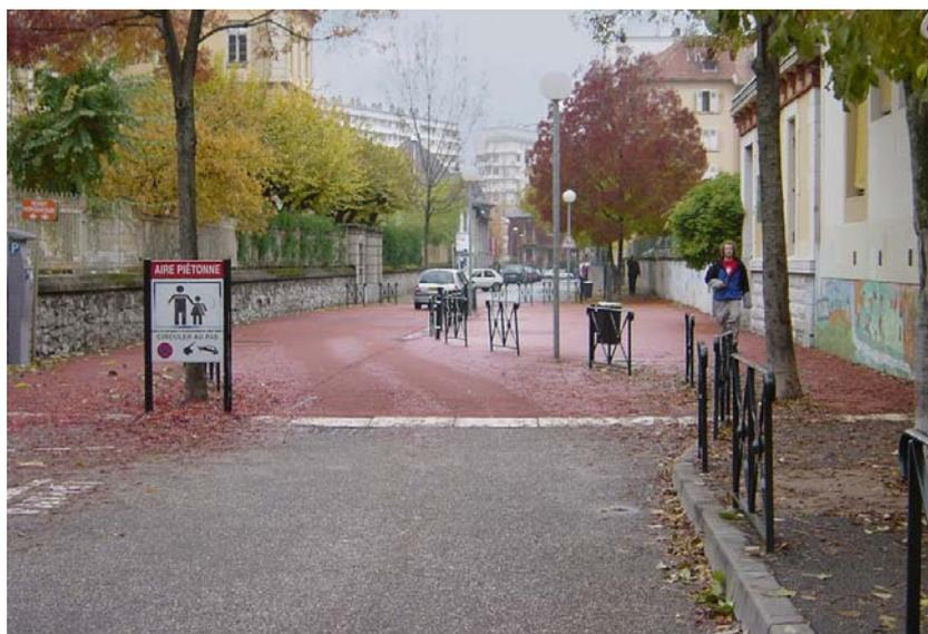
**Figura 1** - Una chicane posta su una piattaforma e realizzata mediante l'allargamento dello spazio pedonale con transenne
