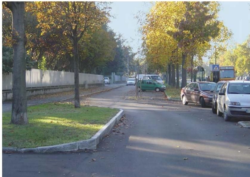
**Figura 6** - Una chicane in cui l'ampio sfalsamento ospita parcheggi disposti a spina di pesce
