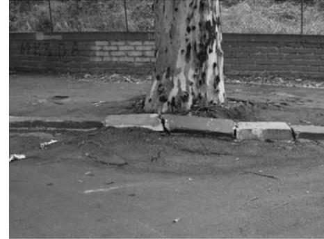
*Figura 2: L'immagine digitale dimostra velocemente la necessità di effettuare la manutenzione di ripristino del cordolo stradale*
