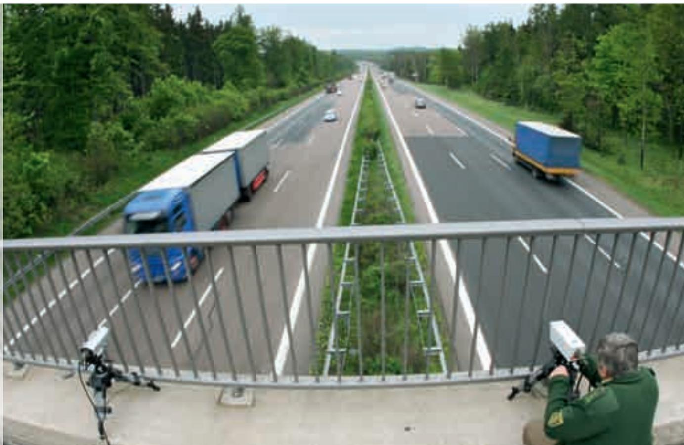
Grazie al radar si possono dimostrare il superamento dei limiti di velocità e la distanza di sicurezza insufficiente, con relative tolleranze.
