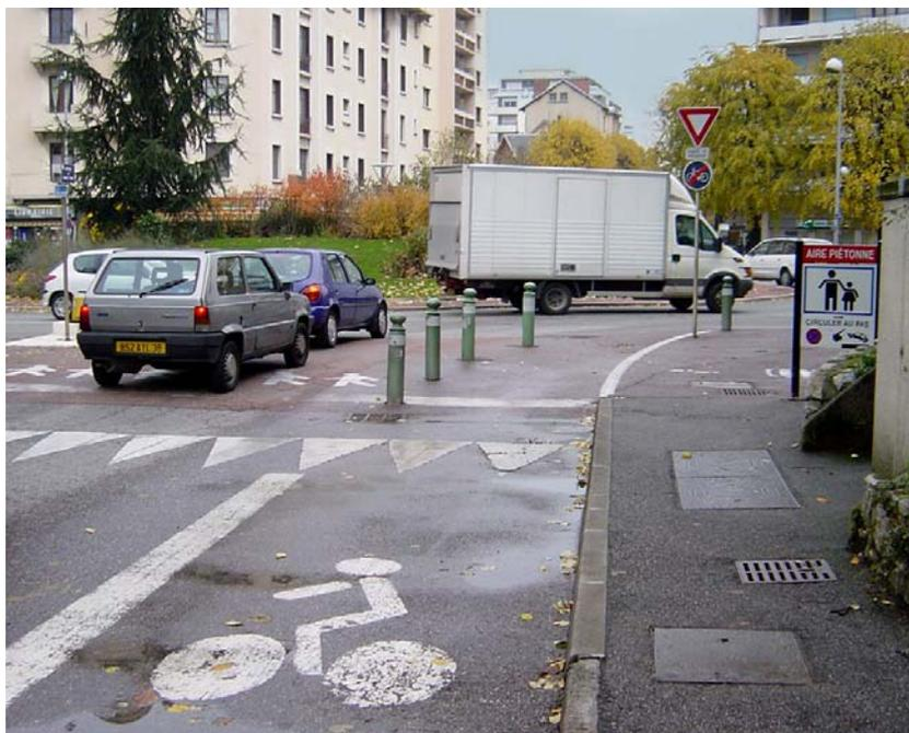
**Figura 18** - Una rotonda a Chambéry in cui la pista ciclabile termina prima della rotonda e il ciclista può scegliere se proseguire sull'anello veicolare o immettersi nel percorso pedonale, che in quel punto si trova allo stesso livello
