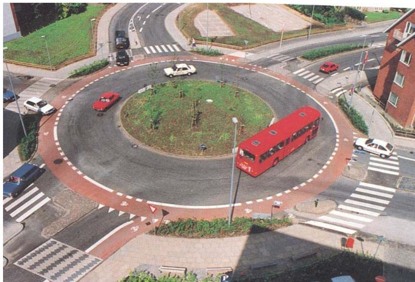
**Figura 20** - Un esempio di rotatoria potenzialmente pericolosa per i ciclisti, in quanto la corsia ad essi destinata è ricavata all'interno della corona giratoria e costituisce di fatto un ampliamento dell'anello veicolare (fonte: sito Internet [www.ite.org](http://www.ite.org))
