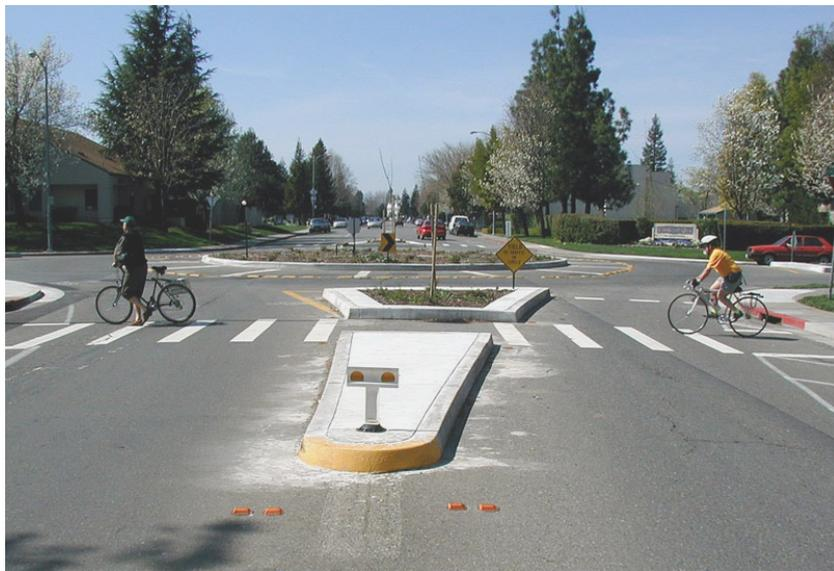
**Figura 14** - Le isole spartitraffico sono elementi molto importanti per la sicurezza delle rotatorie (fonte: sito Internet <http://www.walkinginfo.org>)
