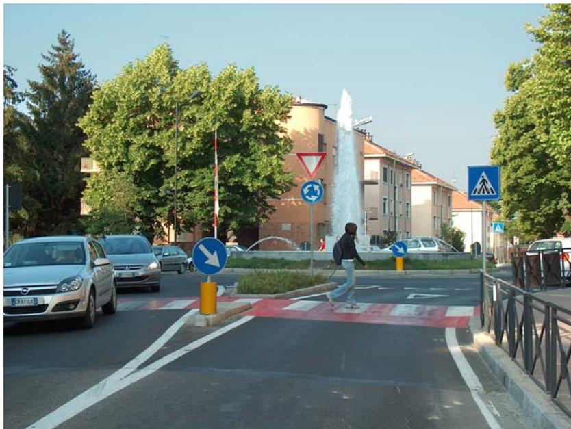
**Figura 2** - Le rotatorie hanno anche la funzione di interrompere la linearità visiva di una strada, evidenziando la presenza di un'intersezione
