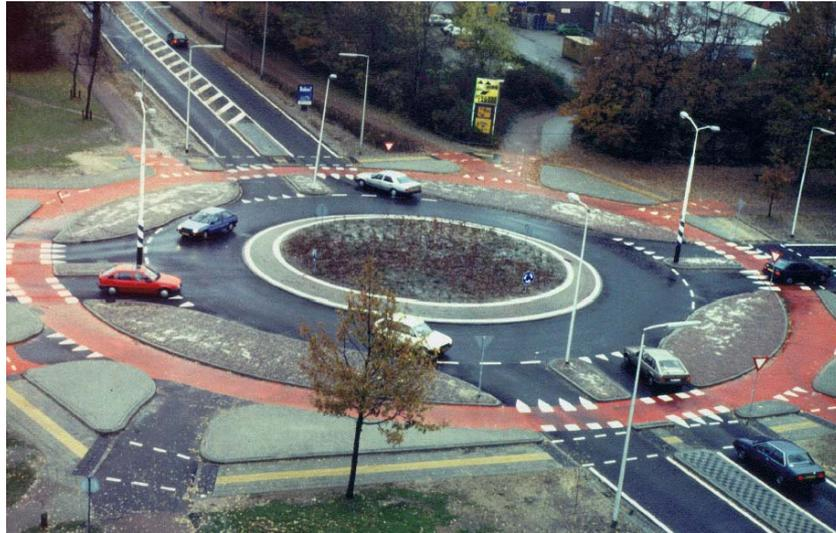
**Figura 21** - Un esempio di rotatoria sicura per i ciclisti, in quanto la corsia ad essi destinata è ricavata all'esterno della corona giratoria, con uno spazio intermedio di fermata per le automobili in entrata e in uscita dalla rotatoria (fonte: European Commission, 1998, Adonis - Analysis and Development of New Insight into Substitution of Short Car Trips by Cycling and Walking)
