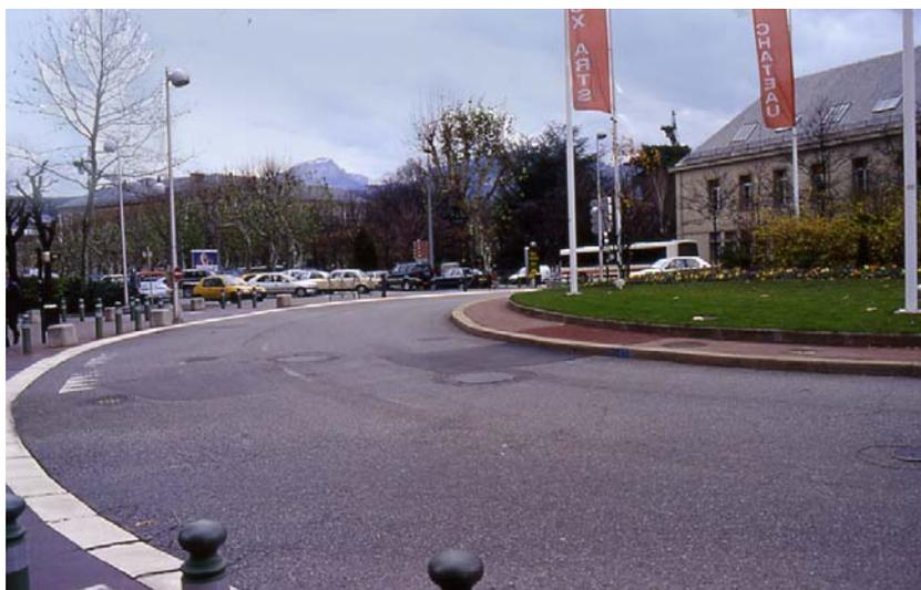
**Figura 13** - L'anello di scorrimento deve essere ad un'unica corsia, con i margini evidenziati, sufficientemente largo per consentire il passaggio dei mezzi pesanti
