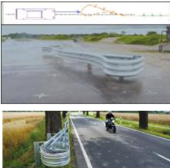
Fig. 8 • Esempi di barriere per protezioni “puntuali”
