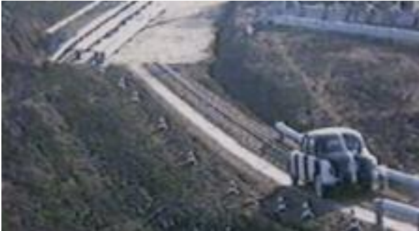
Fig. 1 • Sito di prova barriera di Cesano (Roma), utilizzato nel 1964 per la verifica delle barriere spartitraffico dell'Autostrada del Sole.
