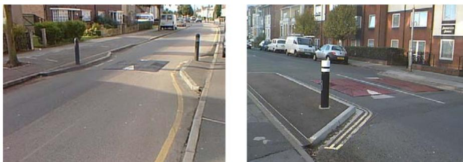
**Figura 7** - Cuscini singoli o doppi posti all'interno di strettoie (fonte: sito Internet <http://www.mini-roundabout.com>)
