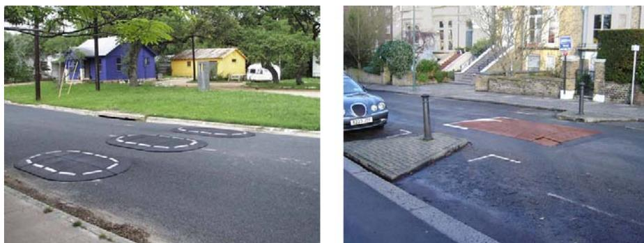
**Figura 1** - Un gruppo di tre cuscini affiancati posti su una strada a doppio senso di marcia (a sinistra) e un cuscino utilizzato in combinazione con una strettoia in una strada a senso unico (a destra)
