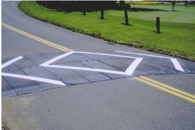
Figura 3 - I dossi lunghi almeno 12 piedi riducono il rischio che il fondo delle automobili urti il manufatto (fonte: sito Internet http://www.ite.org )
