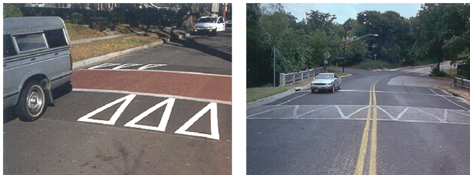
Figura 10 - Due attraversamenti pedonali statunitensi con i triangoli disegnati sulle rampe (fonte: ITE - Institute of Transportation Engineers, 1999, Traffic Calming: State of the Practice )
