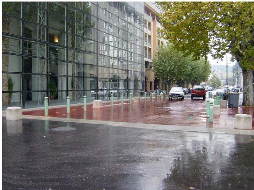
Figura 2 - Un attraversamento pedonale rialzato di grandi dimensioni, posto davanti a un edificio pubblico
