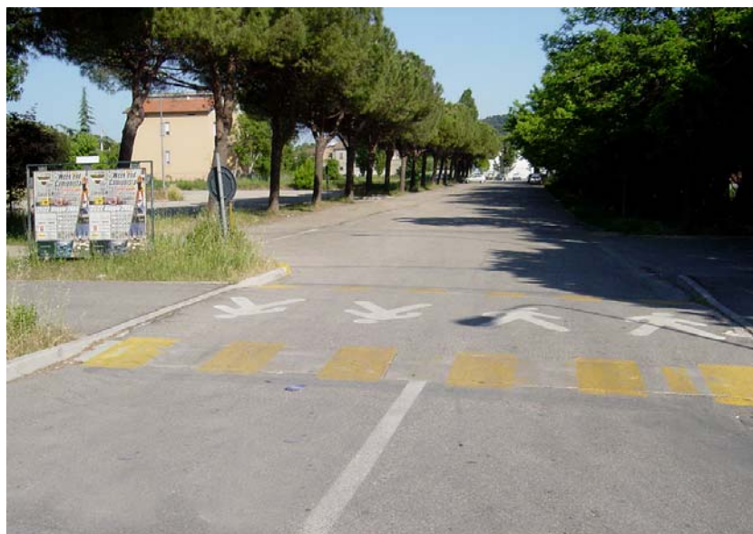
Figura 13 - Un attraversamento pedonale a Cattolica, realizzato ispirandosi al modello adottato a Chambéry
