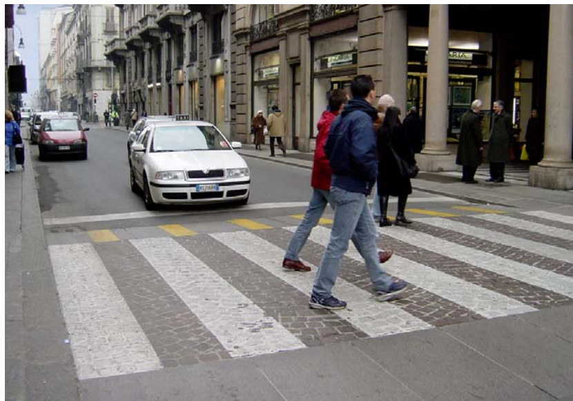
Figura 3 - L'attraversamento pedonale rialzato costringe i veicoli a rallentare e migliora la sicurezza dei pedoni
