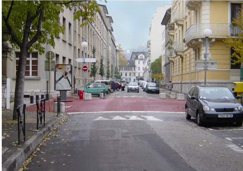
Figura 6 - Un'intersezione rialzata è ben visibile se colorata in modo diverso rispetto al resto della pavimentazione stradale
