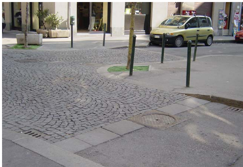
Figura 1 - Un'intersezione rialzata nel centro storico di una città italiana. Si noti la presenza dei chockers
