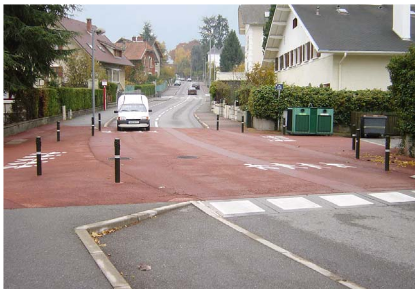
Figura 2 - Un'intersezione rialzata in ambito residenziale in Francia. L'area sopraelevata è realizzata con pavimentazione di colore rosso
