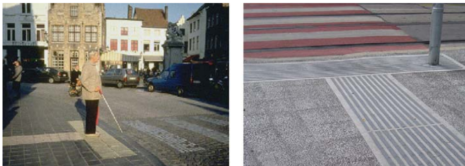
Figura 5 - Piastrelle con finitura in rilievo segnalano alle persone con disabilità visive la presenza di un attraversamento pedonale
