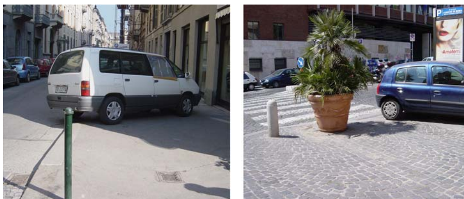
Figura 3 - Se la sosta nei pressi dell'intersezione non è fisicamente impedita con dissuasori, l'allargamento dei marciapiedi spesso viene occupato dai veicoli (o da elementi d'arredo mal posizionati, come il vaso nella figura di destra)
