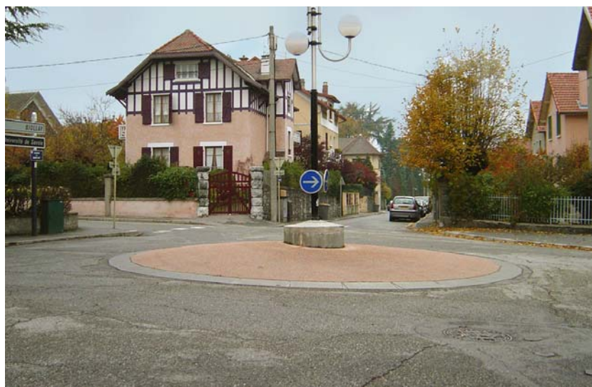
Figura 1 - Una minirotonda con l'isola centrale parzialmente sormontabile
