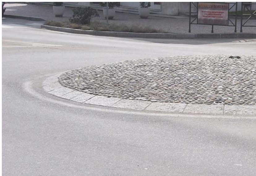
Figura 3 - Un'isola centrale completamente sormontabile, ma realizzata con ciottoli in rilievo, in modo tale da arrecare disagio alle automobili che la percorrano
