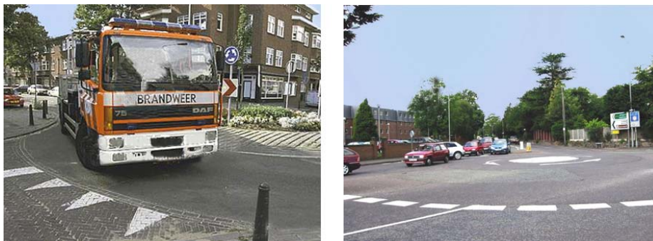
Figura 9 - Una minirotatoria parzialmente sormontabile (a sinistra) facilita il passaggio dei mezzi pesanti e di emergenza, mentre una rotatoria semplicemente dipinta sulla pavimentazione (a destra) non garantisce il corretto comportamento di tutti gli utenti
