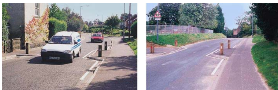
Figura 1 - Due strettoie simmetriche, realizzate mediante l'allargamento dei marciapiedi e l'inserimento di attraversamenti pedonali (fonte: sito Internet http://www.walkinginfo.org )
