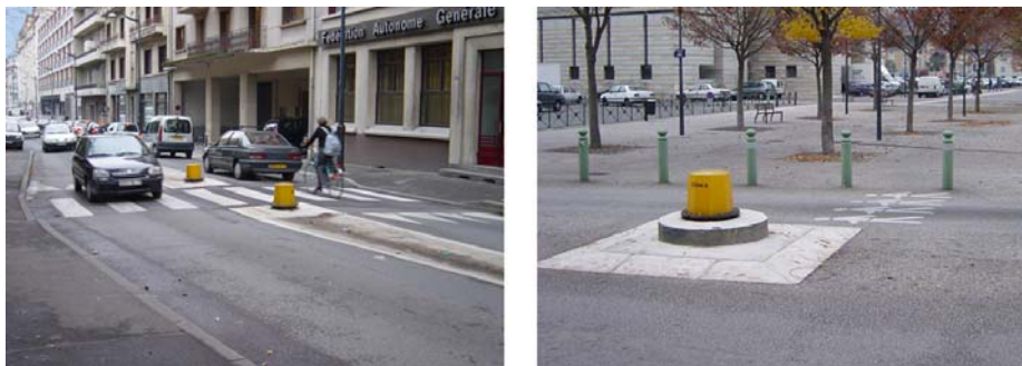
Figura 5 - Due esempi di isole salvagente parzialmente sormontabili, dotate di elementi fissi luminosi
